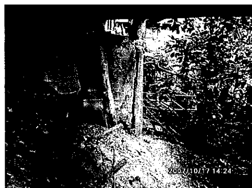
รอยร้าวที่เสาบ้านเนื่องจากดินมีการเคลื่อนตัว
