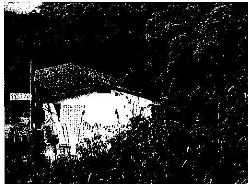
อาคารเรียนโรงเรียนบ้านสองพี่น้อง
