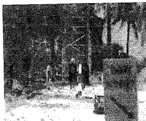
ขั้นตอนที่ 12 ทำเครื่องหมายแสดงว่ามีสายไฟฟ้าแรงสูงฝังอยู่ในบริเวณ terminal ที่ติดตั้งสายเคเบิลและสภาพพื้นที่มีการฝังกลบสายเคเบิลเรียบร้อยแล้ว
