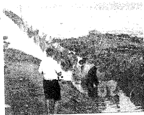
ขั้นตอนที่ 8 ลากสายเคเบิลเข้าฝั่ง โดยมีทุ่นลมนรองรับสายเคเบิล
