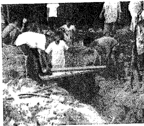
ขั้นตอนที่ 11 การฝังกลบสายเคเบิลบนฝั่ง ซึ่งจะกระทำเหมือนกันทั้งสองฝั่ง
