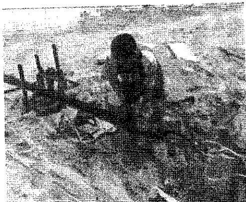
ขั้นตอนที่ 9 ดึงสายเคเบิลบนฝั่งเพื่อนำสายเคเบิลไปยัง terminal โดยมีรถรองรับเป็นระยะ ๆ
