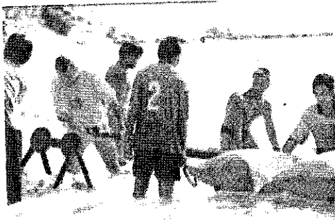
ขั้นตอนที่ 5 ดึงสายเคเบิลขึ้นฝั่งไปยัง terminal เพื่อทำการยึดสายและติดตั้งสายเคเบิล
