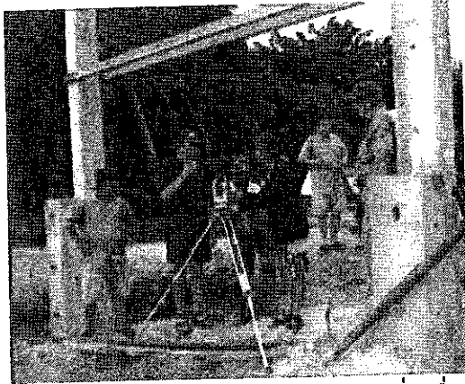
ขั้นตอนที่ 1 ก่อสร้าง terminal บนฝั่งเพื่อเป็นจุดรองรับสายเคเบิลใต้น้ำ
