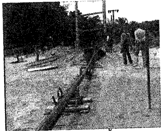
ขั้นตอนที่ 5 ดึงสายเคเบิลขึ้นฝั่งไปยัง terminal เพื่อทำการยึดสายและติดตั้งสายเคเบิล
