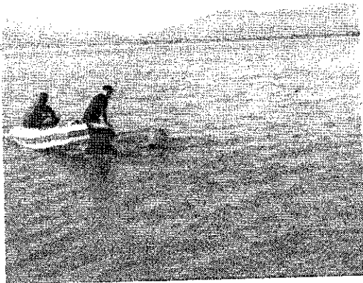
ขั้นตอนที่ 7 เมื่อได้ความยาวของสายเคเบิลตามที่ต้องการแล้วทำการตัดสายเคเบิล ติดทุ่น ปล่อยลงทะเล และดึงสายเคเบิลขึ้นเรือเล็ก เพื่อที่จะลากสายเคเบิลเข้าฝั่ง
