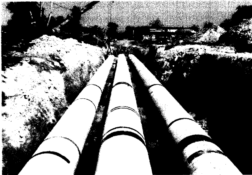
ภาพงานก่อสร้างท่อส่งน้ำ
