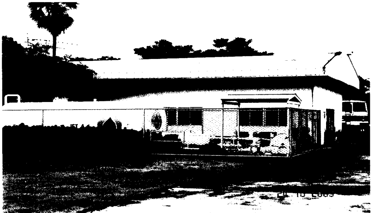
อาคารคลังพัสดุและถังบรรจุเชื้อเพลิง JET A - 1 สนามบินคลองหลวง จ. ปทุมธานี
