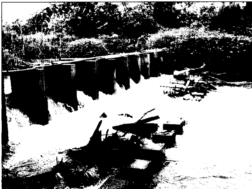
ปรับปรุงฝายวังไผ่พร้อมประตูระบายน้ำ หมู่ที่ 11 บ้านป่าอ้อดอนชัย ตำบลป่าอ้อดอนชัย อำเภอเมือง จังหวัดเชียงราย พิกัด 47 Q NC 792 - 948 ระวาง 4948 I
