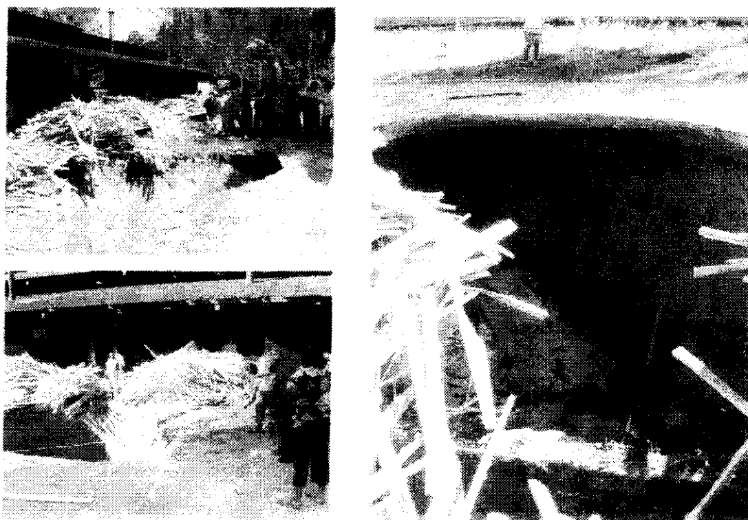
รูปที่ 1 ลักษณะโดยทั่วไปของหลุมยุบบริเวณอำเภออ่าวลึก กระบี่
